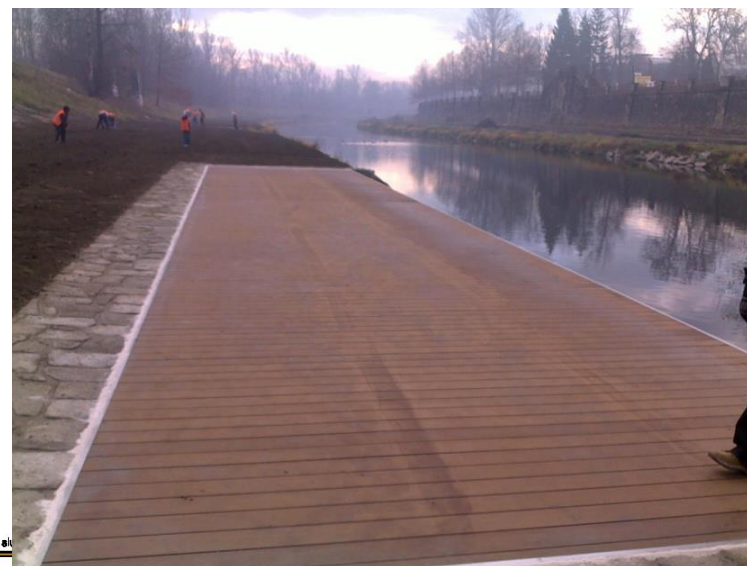
betonová deska ve spádu
